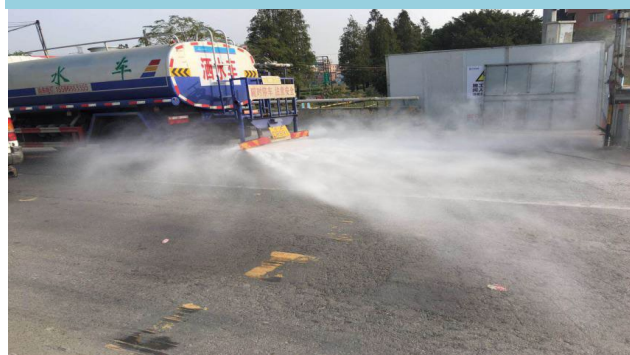
厂区道路降尘
