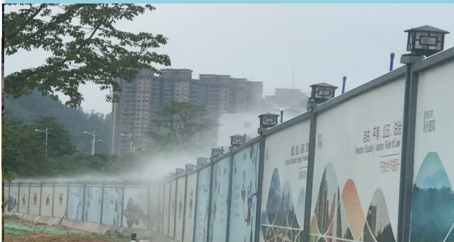
围墙喷淋系统
