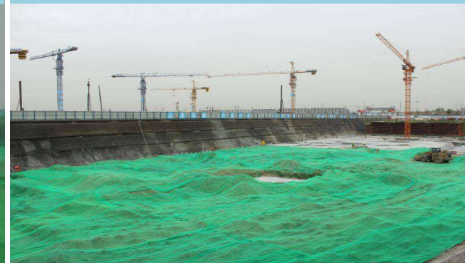
建筑土方开挖
