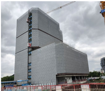
D1 钢管脚手架挂冲孔钢板网
