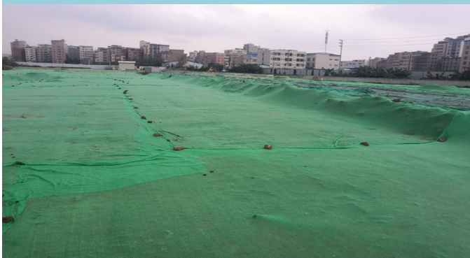
工程渣土、建筑垃圾
