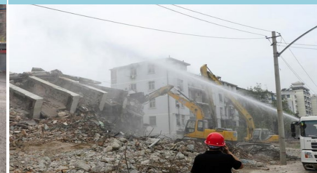
拆除工程降尘
