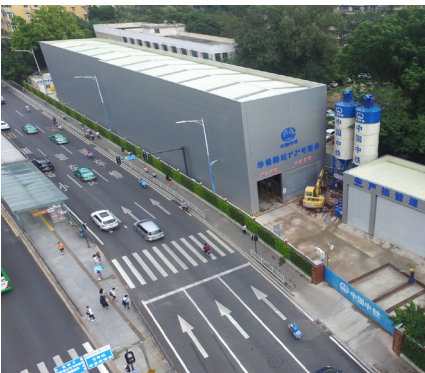
D3 环境敏感地区基坑工程包裹式围蔽
